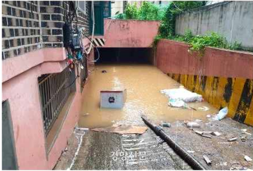
2022년 일가족 3명이 집안에 고립돼 사망한 서울 관악구 신림동 다세대주택의 반지하층. 경향신문 : ‘코드A’ 접수에도 관악구 반지하 출동 늦었던 경찰-소방 : 2022.08.11
